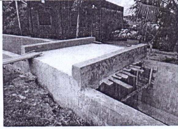
চিত্র-৩: যাতায়াতের জন্য মাষ্টার ডেইনের উপর নির্মিত কালভার্ট
