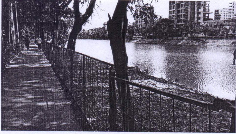
চিত্র: উত্তরা লেকে ওয়াকওয়ে নির্মাণ।
