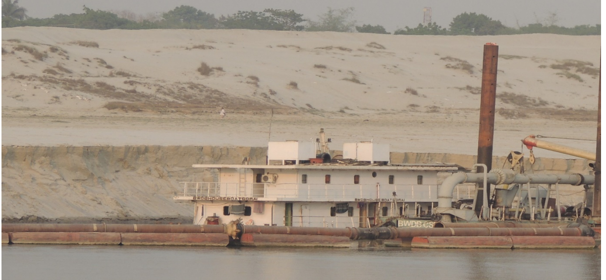
চিত্র ৩.১২ মঙ্গলবাড়িয়া গ্রোয়েন সংলগ্ন এলাকায় সরু চ্যানেল আকারে (৬০ মিটার বেড উইথ) ডেজিং কার্যক্রম, পাশেই পলির উল্লম্ব স্তুপ, কুষ্টিয়া সদর
