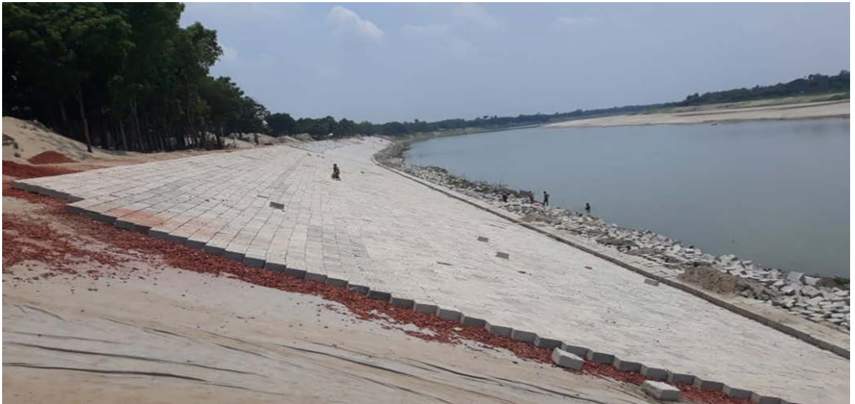
চিত্র ৩.১৫ প্যাকেজ W-33 তীর রক্ষা কাজের চিত্র, সিসি ব্লক ডাম্পিং ও গ্লেসিং, খোকসা, কুষ্টিয়া
