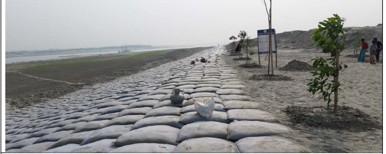
চিত্র ৩.৮ গড়াই অফটেকে জিও ব্যাগ দ্বারা স্লোপ প্রতিরক্ষা কাজ ও বনায়ন, তালবাড়িয়া
