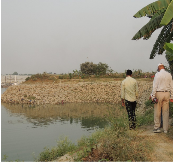
চিত্র ৩.৬ গ্রোয়েনের মেরামত কাজ চলমান থাকলেও অগ্রগতি কম, মোঞ্জলবাড়িয়া, কুষ্টিয়া সদর
