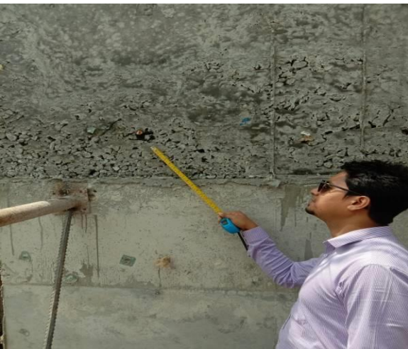
চিত্রঃ ঢালাই পরবর্তীতে রেইনফোর্সমেন্ট বের হয়ে আছে
