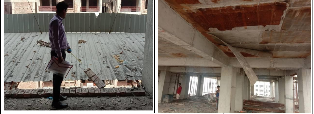
চিত্রঃ সেফটি ক্যানোপি এবং স্টিল সাঁটার অপসারণ সম্পর্কিত
