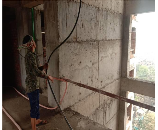
চিত্রঃ শেয়ার ওয়াল পর্যবেক্ষণ
