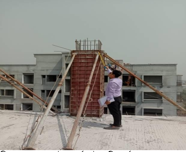
চিত্রঃ কলাম এর রেইনফোর্সমেন্ট কাটিং পর্যবেক্ষণ
