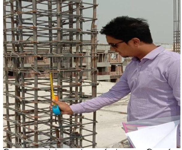
চিত্রঃ কলামের টাই এর রেইনফোর্সমেন্ট এর স্পেসিং পর্যবেক্ষণ
