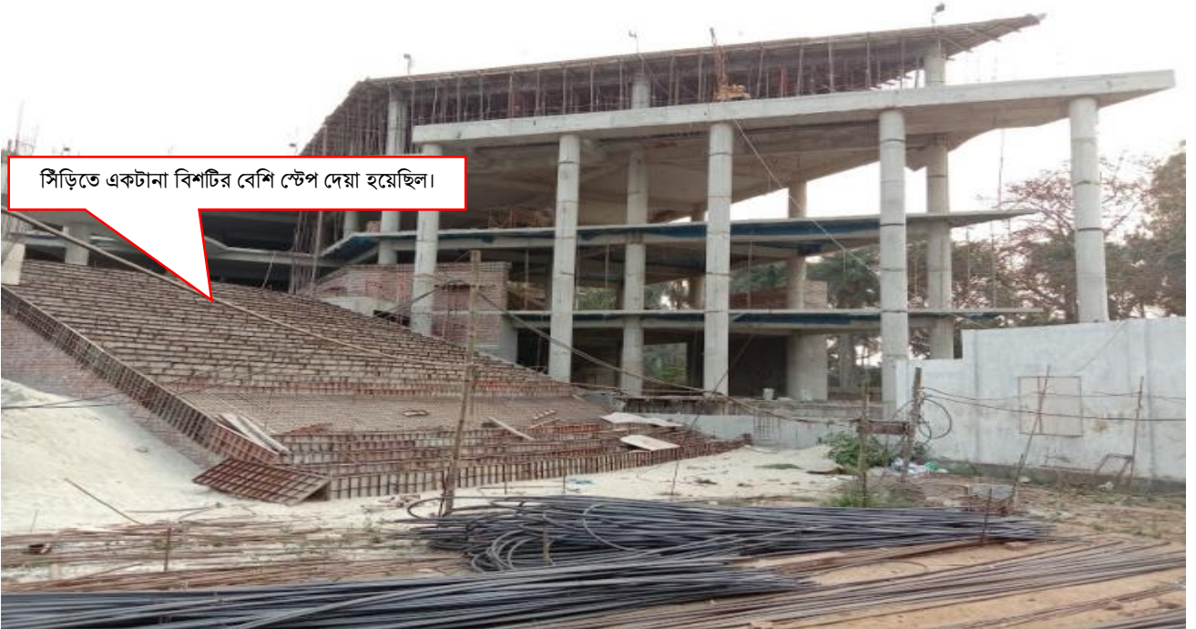
চিত্রঃ ৩.৭.৩: সিঁড়িতে একটানা বিশটির বেশি স্টেপ দেয়া হয়েছে এবং ব্যবহৃত রডে রাস্ট পড়ে গিয়েছে।
