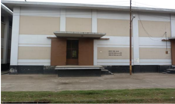
নবনির্মিত একটি খাদ্য গুদাম, দেওয়ানহাট, চট্টগ্রাম: চিত্র-০১
