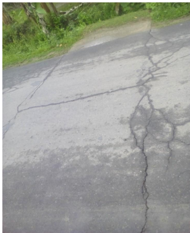
চিত্র ৬.৪ নেত্রকোণা-মোহনগঞ্জ সড়কের ৪র্থ কিমিতে বক্স কালভার্টের এপ্রোচের বর্তমান অবস্থা।
