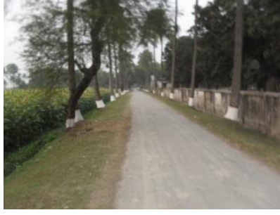
আভ্যন্তরীণ সড়ক নির্মাণ
