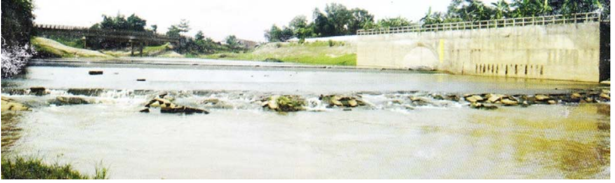
চিত্র ৭.৬: হালদা নদীতে স্থাপিত রাবার ড্যাম ও পানি প্রবাহের বর্তমান অবস্থা (Source: BFRI-BUET Study Report 2016)
