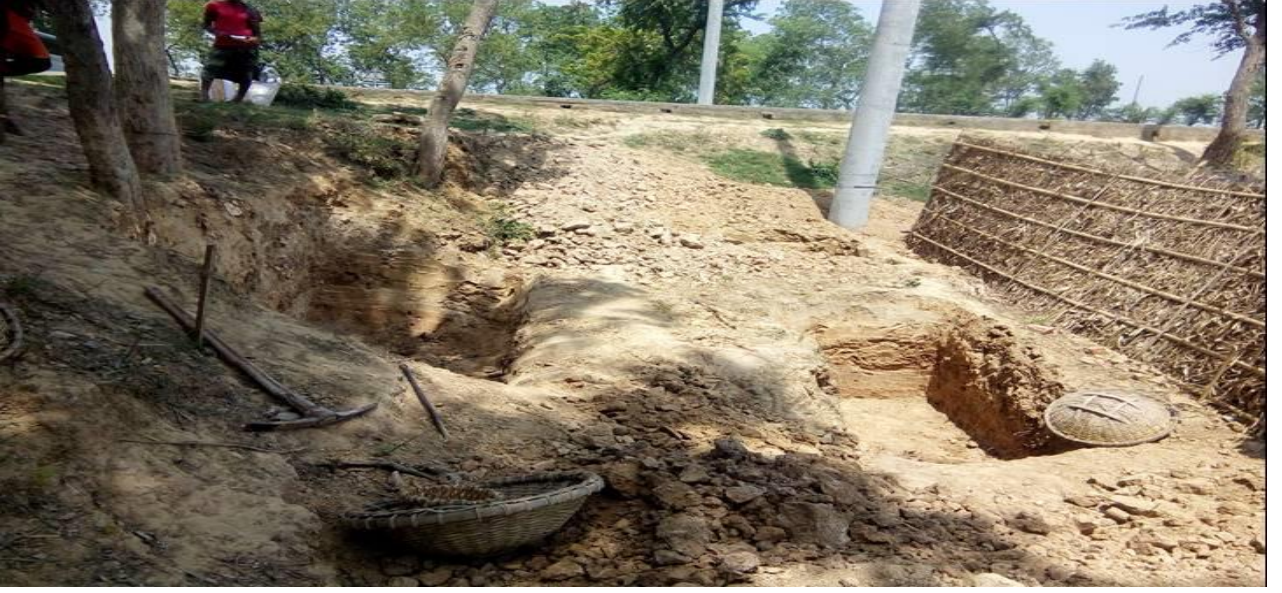
ছবিঃ Embankment সংলগ্ন স্থানে খনন কাজ চলছে (পোস্ট নম্বর ৩১২/১৪ এর নিকটে )
