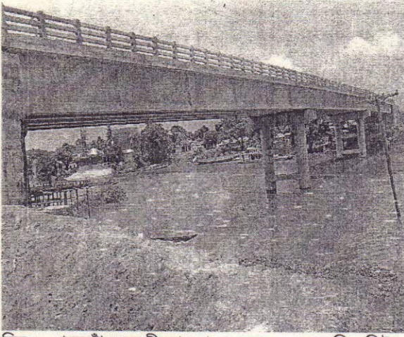
চিত্র ১: গফরগাঁও-বরমী-মাওনা সড়কের ২৬তম কি: মিটারে সুতিয়া নদীর উপর নির্মিত ত্রিমোহনী সেতু।
