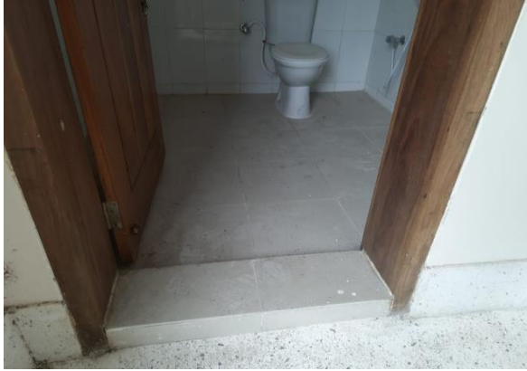
চিত্র: ৩.৫ ডিজেবল ছাত্র-ছাত্রীদের জন্য টইলেটের প্রবেশ পথ খাড়া;
