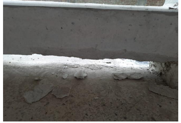
চিত্র: ৩.৪ পলেস্তারা খসে যাচ্ছে
