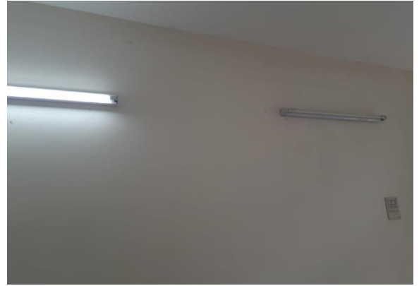
চিত্র: ৩.৬ ত্রুটিপূর্ণ ইলেকট্রিক রড বাব্ব
