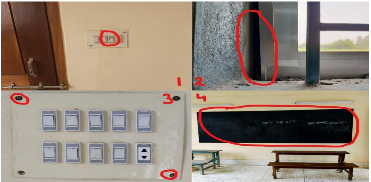
চিত্র: ৩.২ ১) অকেজো ও নিম্নমানের বৈদ্যুতিক সুইচ ২) জানালা প্লাস্টারের মাঝে ফাঁক ৩) বৈদ্যুতিক সুইচের বোর্ডে এসএস এর পরিবর্তে এমএস জং ধরা স্ক্রু ৪) সাদা ও কালো বোর্ডের পরিবর্তে শুধু কালো বোর্ড
