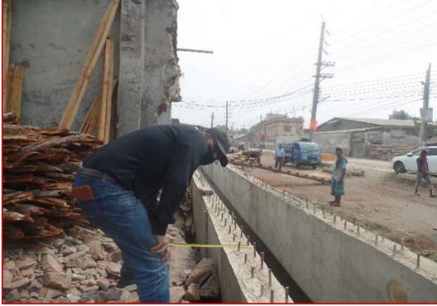
চিত্র: ৩.২- ডেন ও ফুটপাত কাজের পরিমাপ ও পর্যবেক্ষণ, কাঠগোলা; তারিখ ১৭/০৩/২০২৩
