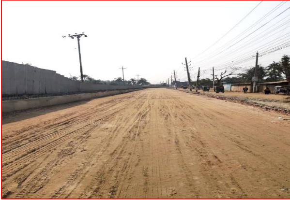
চিত্র: ৩.৩-ডেন ও সাব গ্রেড ওয়ার্ক বান্দাবাজার-শিপ ইয়ার্ড; তারিখ ১৭/০৩/২০২৩
