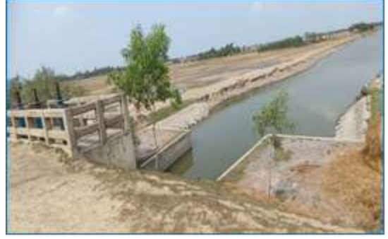
চিত্র-৬: Drainage Sluice (DS-10) চেইনেজ ২.৯৬০ কি.মি.
