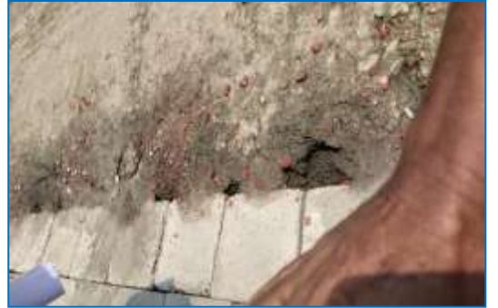
চিত্র নং: ৬, ঢাল প্রতিরক্ষা কাজের ব্লকের বাঁধের উপরের অংশে গর্ত।
