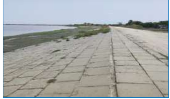
চিত্র-৭: বাঁধের ঢাল প্রতিরক্ষা কাজ (চেইনেজ কি.মি. ৯.০০ থেকে কি.মি. ১০.০০ (১.০ কি.মি.))
