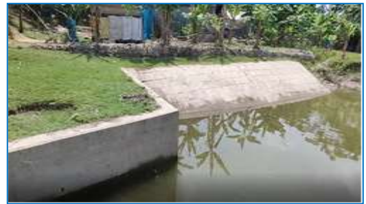
চিত্র-৩: Flushing Sluice/Inlet (FS-7) চেইনেজ কি.মি. ২০.২১৪
