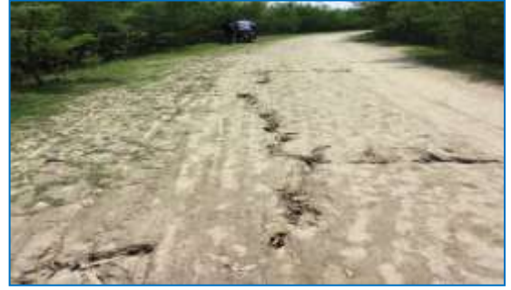
চিত্র-১: বাঁধ নির্মাণ (চেইনেজ কি.মি. ২০.০০ থেকে কি.মি. ২৪.০০)
