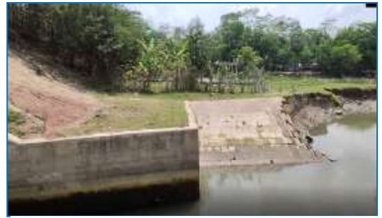
চিত্র-২: Drainage Sluice (DS-6) চেইনেজ ১৯.৭৩৬ কি.মি.
