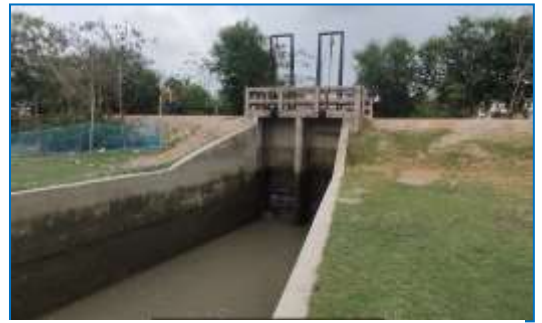
চিত্র-৪: Drainage Sluice (DS-7) চেইনেজ ২৫.৩৩০ কি.মি.
