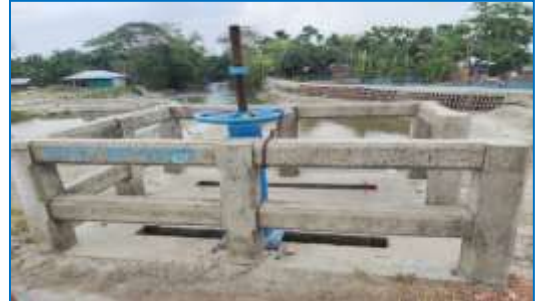
চিত্র-৩: Drainage Sluice (DS-6) চেইনেজ ২০.৫৩ কি.মি.
