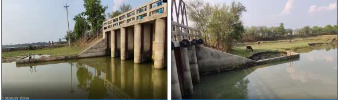
চিত্র- ১ ও ২: Drainage Sluice (DS-1) কি.মি.চেইনেজ ৪.৯১ কি.মি.
