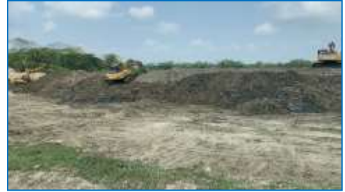
চিত্র-৭: বাঁধ নির্মাণ কাজ পর্যবেক্ষণ
