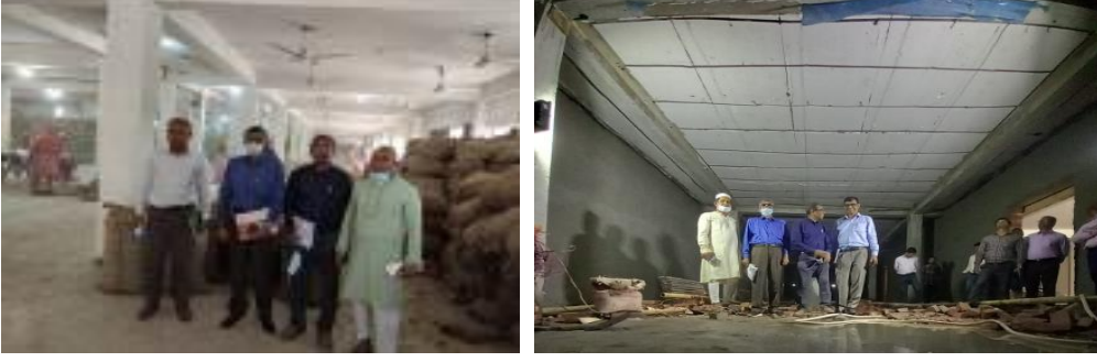
চিত্র: ডোমার ইন্সুলেশন প্রতিস্থাপন সরেজমিন পরিদর্শন
