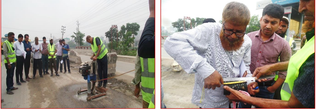
চিত্র: ৩.১- মাঠ পর্যায়ে কোর কাটিং ও এর অবস্থা পরিদর্শন
