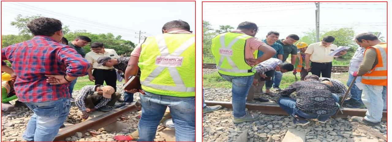
চিত্র: ৩.৩- মাঠ পর্যায়ে ব্যালাস্ট এর অবস্থা পরিদর্শন
