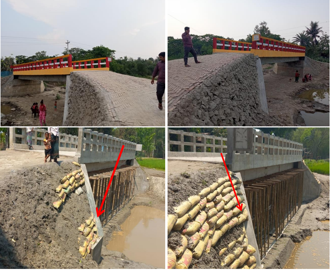
চিত্র-৩.৮: দেলুটি ইউনিয়ন, পাইকগাছা উপজেলা খুলনা এবং তালুখালী মৌজার খাড়া নদীর উপর নির্মিত ব্রিজ পীরগাছা উপজেলা রংপুর। এই ব্রিজগুলোর উচ্চতা বেশি, গাইড ওয়াল ছোট এবং খালের দুই পাশে মাটি ভরাট করার প্রয়োজন হয়েছে।
