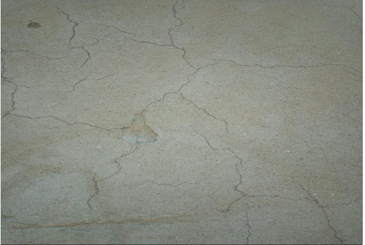
চিত্র-৯: একটি বীর নিবাসের দেওয়ালের প্লাস্টারে ফাটল (উপজেলা-সোনারগাঁও, জেলা-নারায়ণগঞ্জ)
