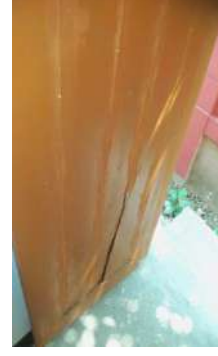
চিত্রঃ দরজার ফিনিশিং-এ ত্রুটি
