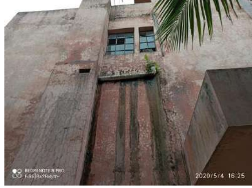
চিত্রঃ ত্রুটিপূর্ণ পানি নিষ্কাশন লাইন
