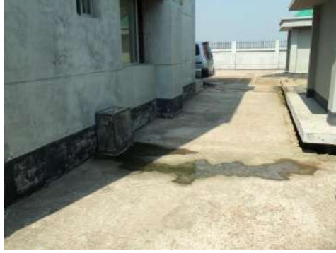
চিত্রঃ ত্রুটিপূর্ণ সুয়ারেজ লাইন
