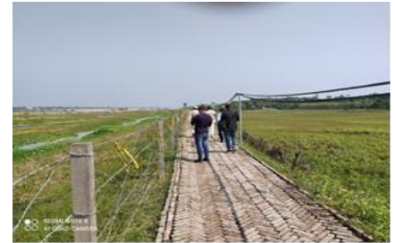
চিত্র ৬: ওয়াকওয়ে পরিদর্শন (ফেব্রুয়ারি ২০২২)
