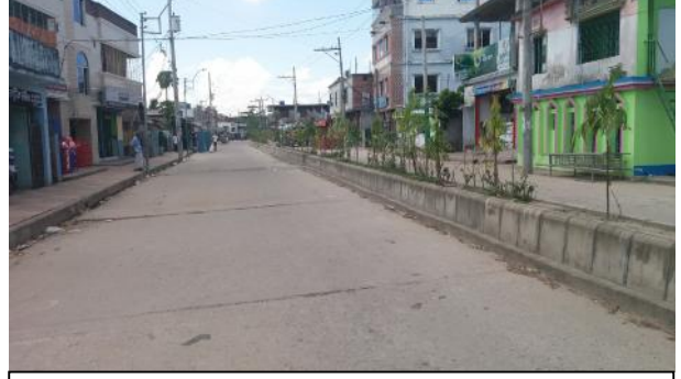
ফেনী পৌরসভার রাস্তা রাস্তা ও ফুটপাথ পরিদর্শন
