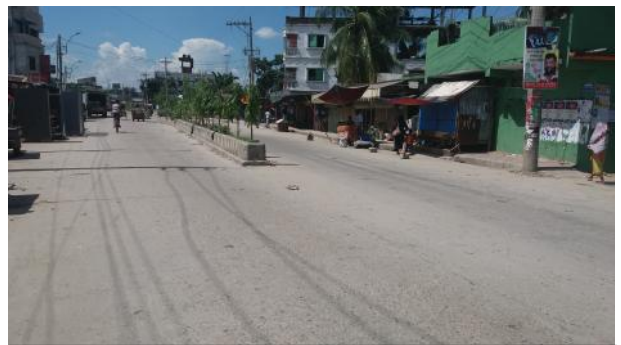
কুমিল্লা সিটি কর্পোরেশনের রাস্তা ও ফুটপাথ পরিদর্শন
