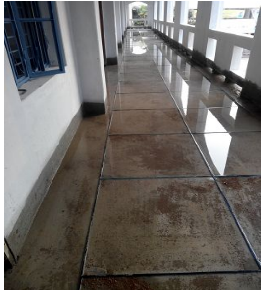
রাজশাহী শহরে শহীদ এ এইচ এম কামারুজ্জামান কলেজের ফ্লোর মোজাইক কাজ পরিদর্শন
