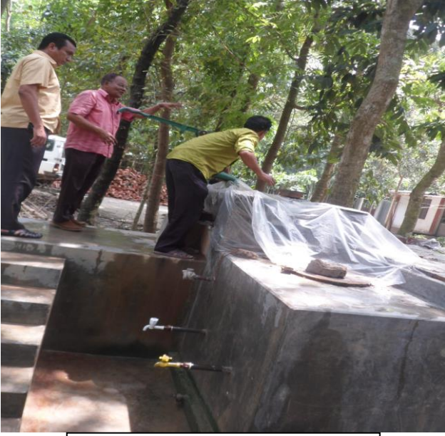
স্থানঃ ফরিদপুর সদর, ফরিদপুর স্থাপনাঃ AIRP সহ টিউবওয়েল
