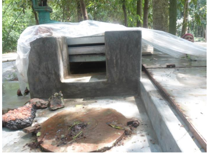
স্থানঃ ফরিদপুর সদর, ফরিদপুর স্থাপনাঃ AIRP সহ টিউবওয়েল
