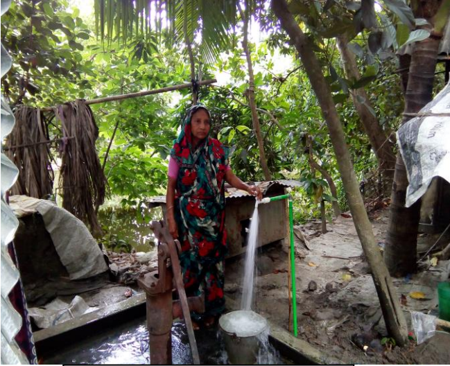
স্থানঃ গদখালী, ঝিকরগাছা, যশোর স্থাপনাঃ পাইপড ওয়াটার স্কীম
