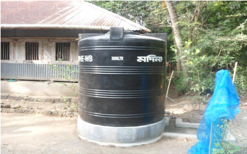
স্থানঃ চিতলমারী, বাগেরহাট স্থাপনাঃ রেইন ওয়াটার হারভেস্টিং
