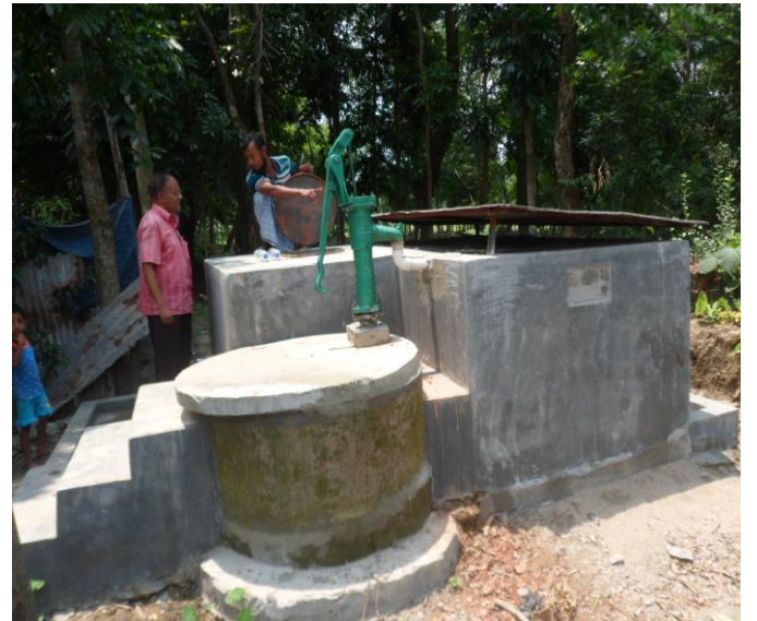
স্থানঃ মিরসরাই, চট্টগ্রাম স্থাপনাঃ রিংওয়েল স্যান্ড ফিল্টার
