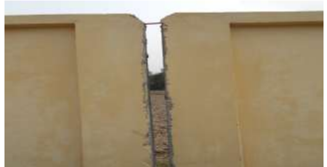
প্রাচীরের এক্সপানসন জয়েন্ট (রাজাবাড়ি হাট, রাজশাহী)
