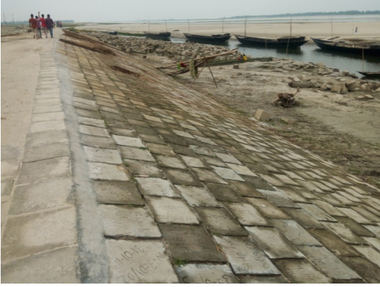
চিত্র ১৩: চিলমারী উপজেলাধীন রমনা এলাকায় কি.মি. ৬৪.৯৪০ হতে কি.মি. ৬৫.০৮০ অংশে নদী-তীর ভাঙ্গন প্রতিরক্ষামূলক সমাপ্ত কার্যক্রম (প্যাকেজ নং কুড়ি-ডব্লিউ-০৭ লট ০১/০২)
