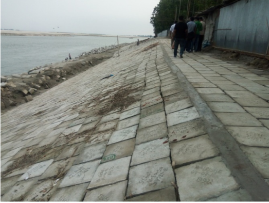
চিত্র ১৫: রমনা এলাকায় কি.মি. ৬৬.৬৩০ হতে কি.মি. ৬৫.৭৬৫ অংশে নদী-তীর ভাঙ্গন প্রতিরক্ষামূলক সমাপ্ত কার্যক্রম (প্যাকেজ নং কুড়ি-ডব্লিউ-১১ লট ০২/০২, আইডি নং ১৮০৬৫)
