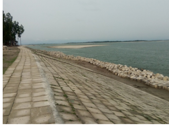
চিত্র ১৬: রমনা এলাকায় কি.মি. ৬৫.৯০৫ হতে কি.মি. ৬৬.০৪০ অংশে নদী-তীর ভাঙ্গন প্রতিরক্ষামূলক সমাপ্ত কার্যক্রম (প্যাকেজ নং কুড়ি-ডব্লিউ-১৪ লট ০২/০২, আইডি নং ১৮০৬৮)
