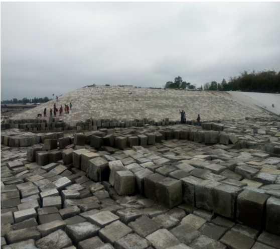
চিত্র -৮: কাচকোল এলাকায় রাণীগঞ্জ ইউনিয়নের ব্রহ্মপুত্র নদের ডান তীরস্থ ৫৭.৩২৭ কি.মি.-এ অবস্থিত কালিরকুড়া ক্রসবার নং ১-এর চলমান মেরামত/পুনর্বাসন কার্যক্রম (প্যাকেজ নং কুড়ি-ডব্লিউ-২০, আইডি নং-৫৯৫৯৫)
