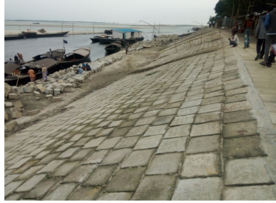
চিত্র ১৪: রমনা এলাকায় কি.মি. ৬৫.২১৫ হতে কি.মি. ৬৫.৩৫৫ অংশে নদী-তীর ভাঙ্গন প্রতিরক্ষামূলক সমাপ্ত কার্যক্রম (প্যাকেজ নং কুড়ি-ডব্লিউ-১০ লট ০১/০২, আইডি নং ১৮০৫৯)
