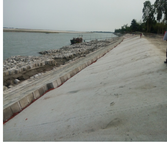
চিত্র ১৮: রমনা এলাকায় কি.মি. ৬৬.২৪০ হতে কি.মি. ৬৬.৩৯০ (প্রকল্পের শেষ প্রান্ত) পর্যন্ত নদী-তীর রক্ষা কাজের অংশ হিসেবে কনক্রিট ব্লকের চলমান পিচিং কার্যক্রম (প্যাকেজ নং কুড়ি-ডব্লিউ-১৫ লট ০২/০২, আইডি নং ১৮০৭২)
