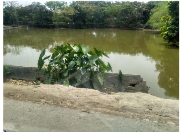
চিত্র: সংস্কারের অভাবে পুরাতন ব্রিক ওয়াল ক্ষতিগ্রস্ত
