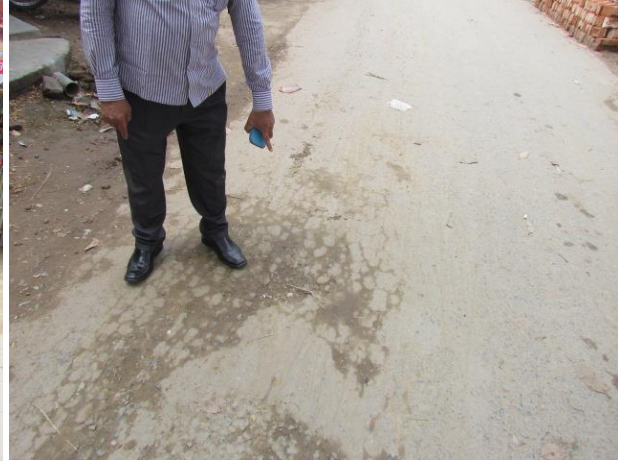
চিত্র: টয়লেটের পানির আউটলেটের কারণে সড়কের ক্ষতিসাধন
