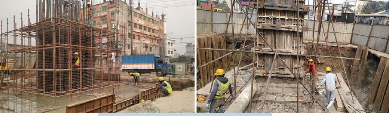
চিত্র ৩.৮: Elevated Section এর পিয়ার নির্মাণ
