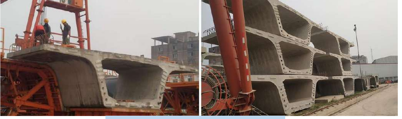
চিত্র ৩.৭: Elevated Section এর Box Girder নির্মাণ
