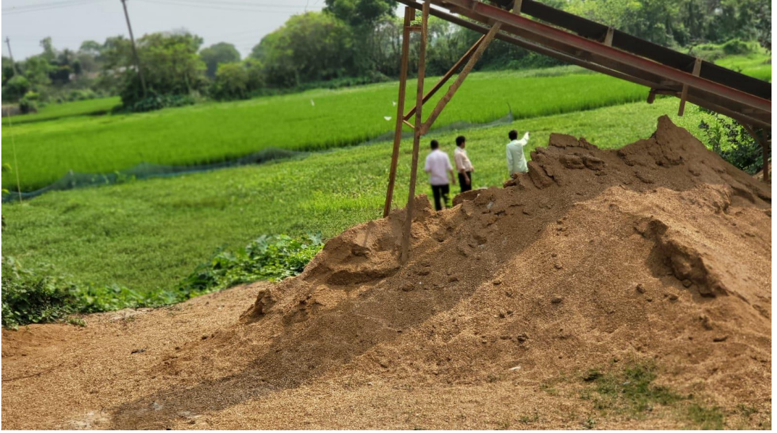
চিত্র ১: নিবিড় পরিবীক্ষণ টিম কর্তৃক প্রকল্প এলাকা সরেজমিনে পরিদর্শন
