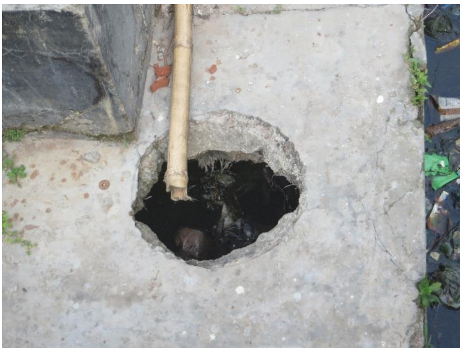
চিত্র। টাঙ্গাইল চীফ জুডিশিয়াল ম্যাজিস্ট্রেট আদালতের পয়ঃনিষ্কাশন ব্যবস্থার খারাপ ব্যবস্থাপনা।
