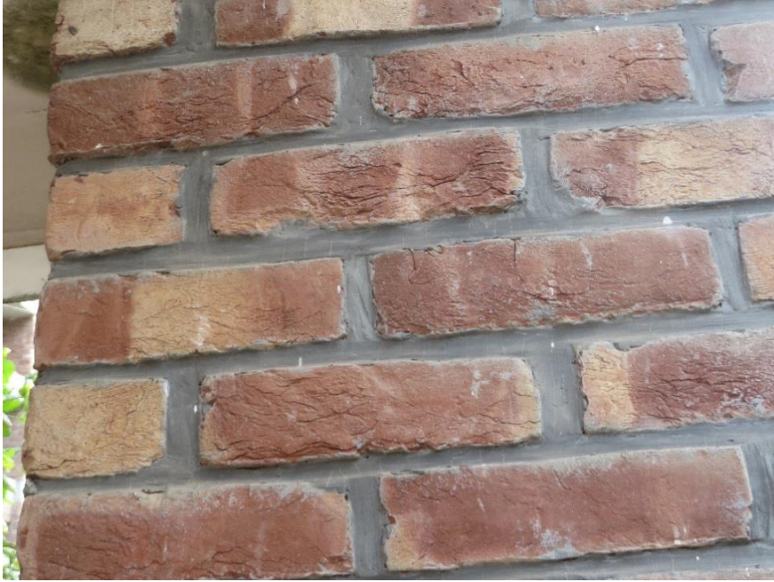
চিত্র। টাঙ্গাইল চীফ জুডিশিয়াল ম্যাজিস্ট্রেট আদালত ভবনের দেওয়ালের পয়েন্টিং কাজ ভালো হয়নি। ইটগুলোর গুণগত মান ভাল নয়।
