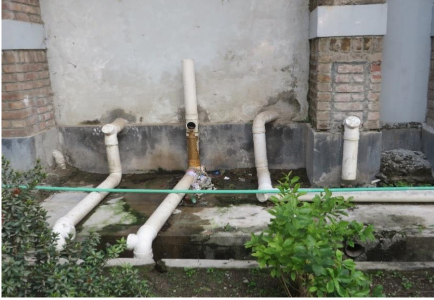
চিত্র। টাঙ্গাইল চীফ জুডিশিয়াল ম্যাজিস্ট্রেট আদালত পয়ঃনিষ্কাশন ব্যবস্থার খারাপ ব্যবস্থাপনা।
