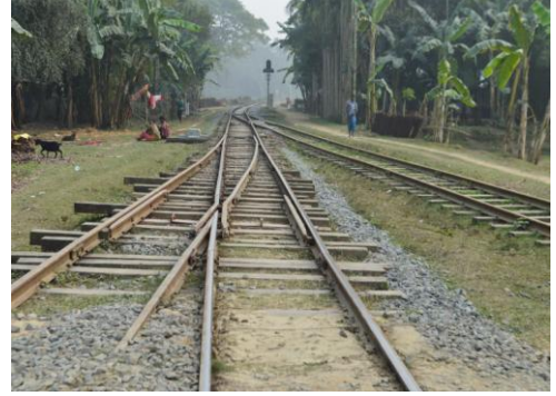
চিত্র-১০: সংস্কারকৃত পি-ওয়ে ও লুপলাইন
