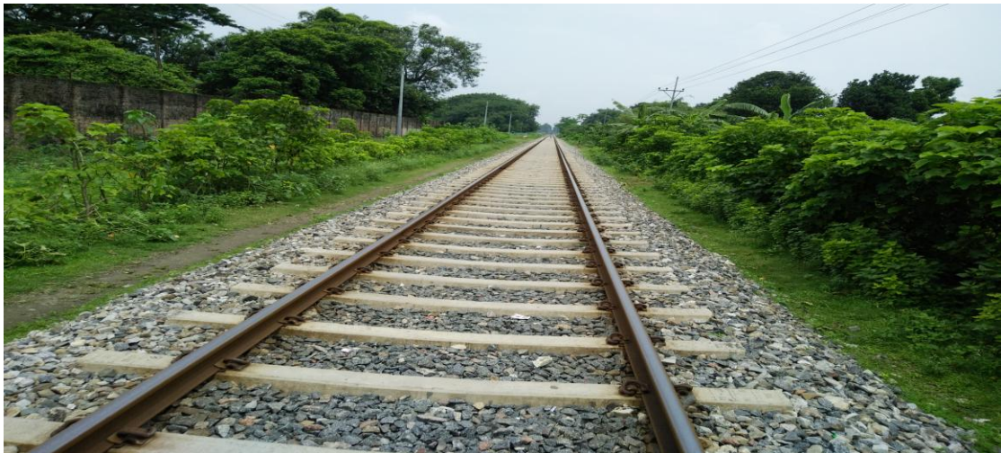
চিত্র-১: নির্মিত রেলওয়ের স্লিপারের নীচে ব্যালাস্ট।
