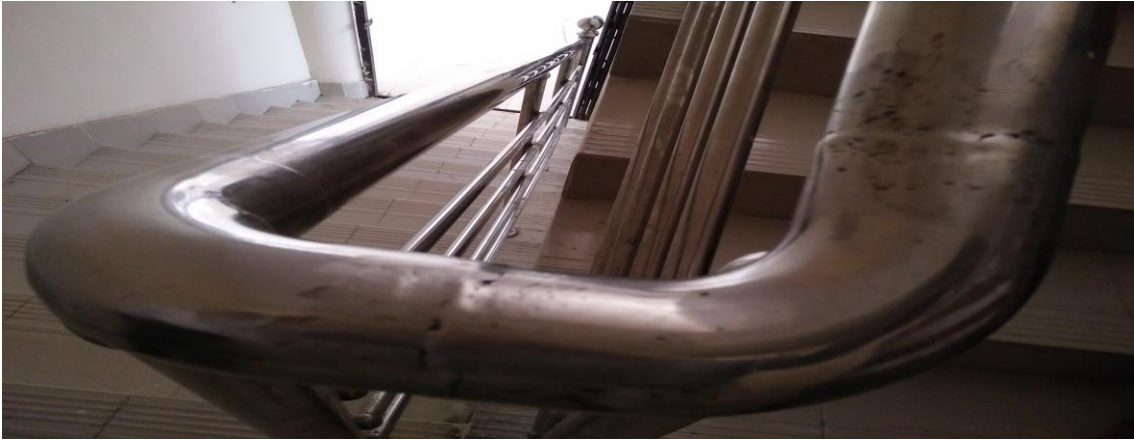
চিত্র-৫: সৈয়দপুর রেল স্টেশনে ব্যবহৃত নিম্নমানের স্টীল রেলিং।
