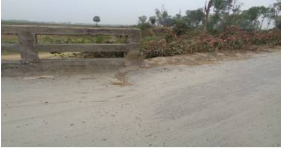
চিত্র-৩: রাস্তা থেকে কালভার্টের উচ্চতা কম এবং এখানে রাস্তার ফিনিশিং ঠিকভাবে করা হয়নি ফলে যানবাহনে প্রতিবার ঝাঁকি খেতে হয়।
