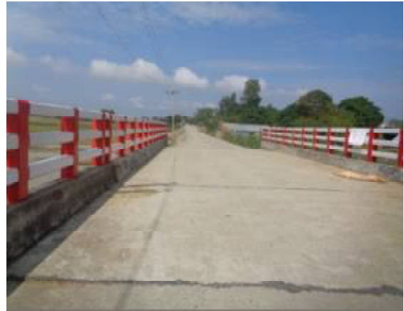
চিত্র-৯: এপ্রোচ রোডের উপর নির্মিত কালভার্ট
