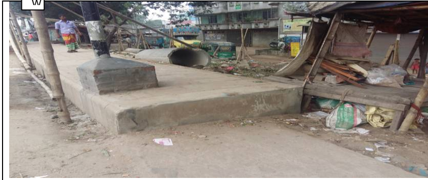
ফুটপাথের স্লোপে ত্রুটি (৩নং চিত্র)
