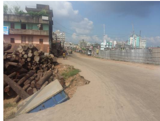
চিত্রঃ এপ্রোচ রোডের একপাশে কিনারাসহ ভেঙ্গে যাওয়া রাস্তা
