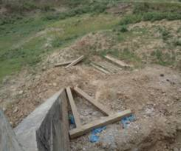
চিত্র-২: কালভার্ট নির্মাণের পর নিচের মাটি এবং পড়ে থাকা বিভিন্ন নির্মাণ সামগ্রী সরানো হয়নি যার ফলে বর্ষার সময় পানি নিষ্কাশনে সমস্যা হতে পারে।
