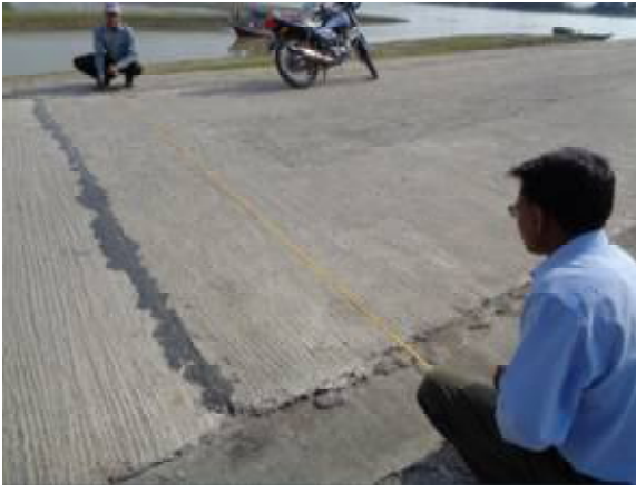
চিত্র-৮: সেতুর এপ্রোচের প্রশস্ততা মেপে দেখা হয়
