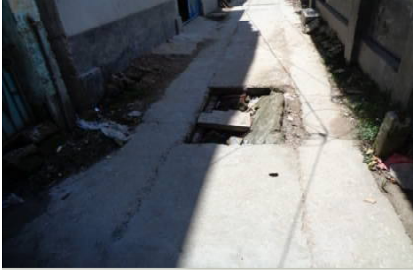
চিত্র:- ভাঙ্গা আরসিসি ডেনের ঢাকনা এবং ময়লা আবর্জনা
