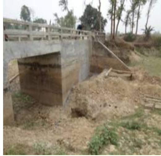
চিত্র-২: কালভার্ট নির্মাণের পর নিচের মাটি এবং পড়ে থাকা বিভিন্ন নির্মাণ সামগ্রী সরানো হয়নি যার ফলে বর্ষার সময় পানি নিষ্কাশনে সমস্যা হতে পারে।
