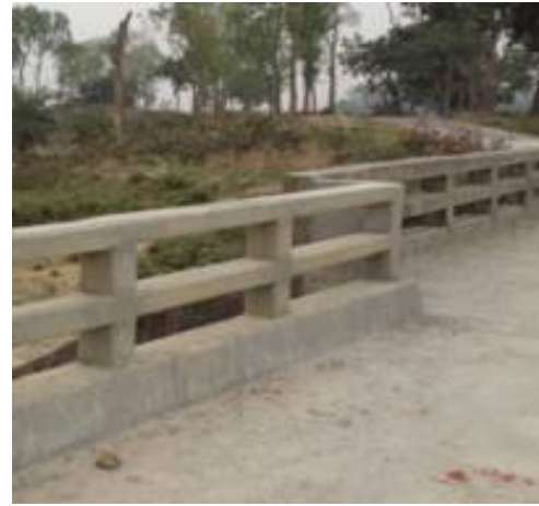
চিত্র-৪: দুটি ভিন্ন প্রশস্ততার কালভার্টের রেলিং।
