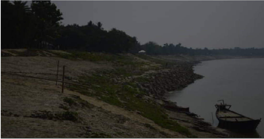
চিত্র-৫: কুষ্টিয়ার কুমারখালীতে গড়াই নদীর তীর সংরক্ষণ।
