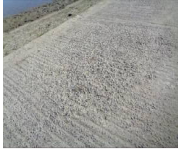
চিত্র-৭: সড়কের ক্ষয়প্রাপ্ত আরসিসির সারফেস
