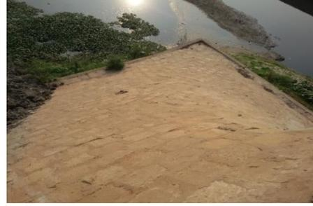
চিত্র-৫ ও ৬: কনক্রিট স্লোপ দ্বারা সেতু এপ্রোচের রক্ষাপ্রদ কাজ
