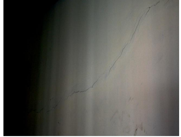
চিত্রঃ ৯) অফিস ব্লকের কক্ষের দেওয়ালের ফাঁটল।
