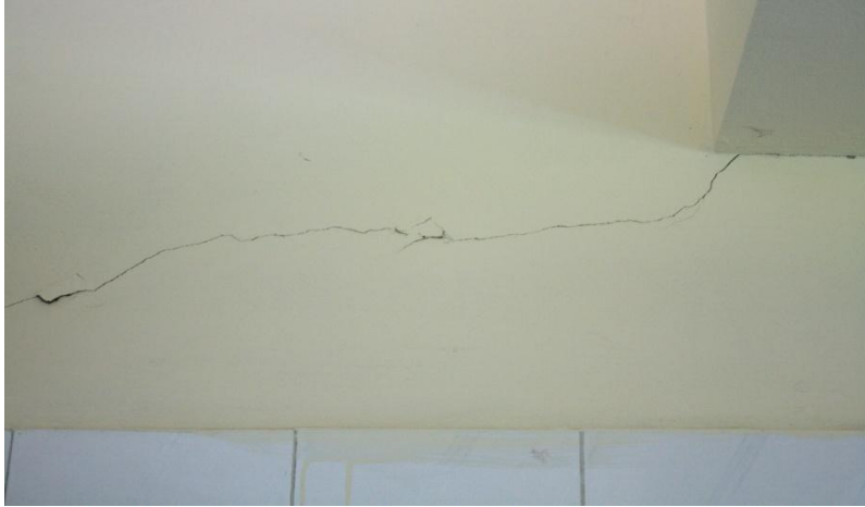
চিত্রঃ ৫) প্রশিক্ষণ ভবনের বাথরুমের দেওয়ালের ফাঁটল।
