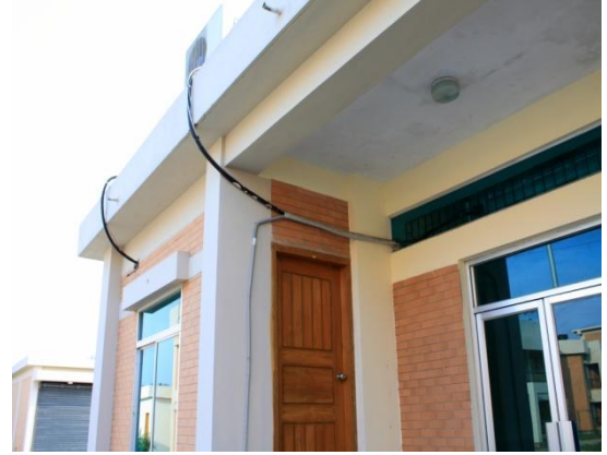
চিত্রঃ ৭) এসির সংযোগ। হোস্টেল ভবনের বাইরের দেওয়াল।
