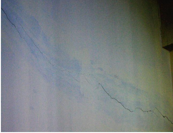
চিত্রঃ ৯) অফিস ব্লকের কক্ষের দেওয়ালের ফাঁটল।
