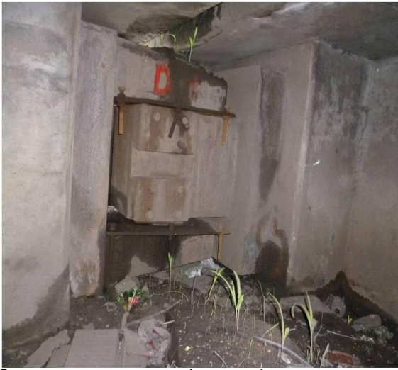
চিত্র ৩: প্রকল্প শুরুমের পূর্বে বক্স-গার্ডারের অভ্যন্তরের Hinge এবং Expansion Joint-সমূহ
