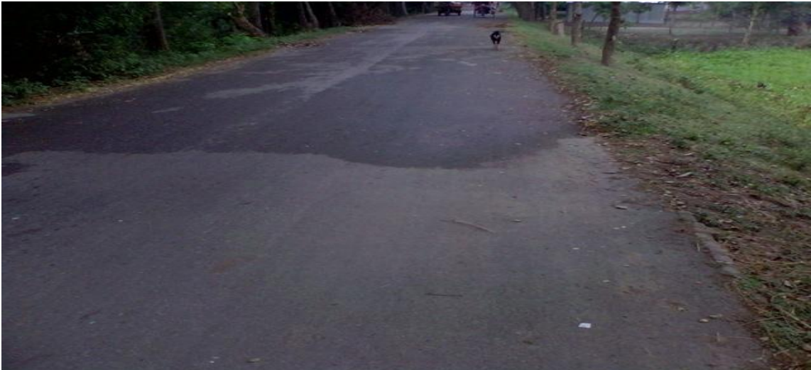
চিত্রঃ ১: পেভমেন্ট লেভেল বরাবর সফট সোল্ডার নেই এছাড়া স্লোপও ১:২ নেই।
