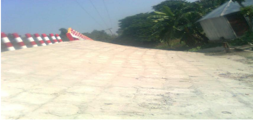
চিত্রঃ ২: সেতুটির এ্যাপ্রোচ সড়কের রক্ষাপ্রদ কাজ ১:২ স্লোপে নির্মাণ করা হয়নি।
