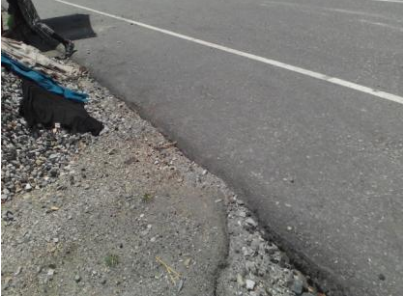
চিত্র-৩, ৪ ও ৫ : নির্মিত সড়ক সার্ফেসিং, বয়কৃত সীলকোট ও কালভার্টের উপরের স্রর
