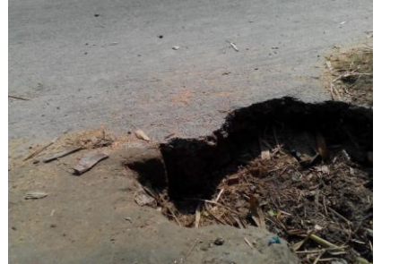
চিত্র-৬, ৭ ও ৮ : নির্মিত কনক্রিট স্লোপ প্রটেকশন, প্যালাসাইডিং ওয়ার্ক ও পেভমেন্টের কিনারা ভাঙ্গা
