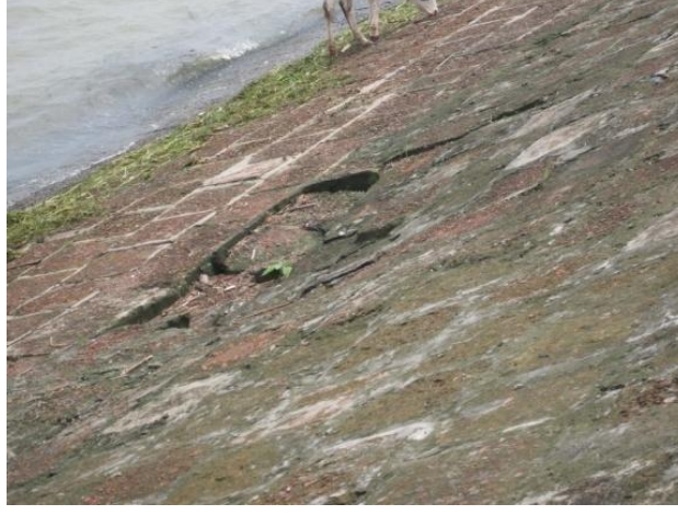
চিত্র-৪: সিসি ব্লক ধসে পড়েছে, পাথরের পরিবর্তে খোয়ার ব্যবহার
