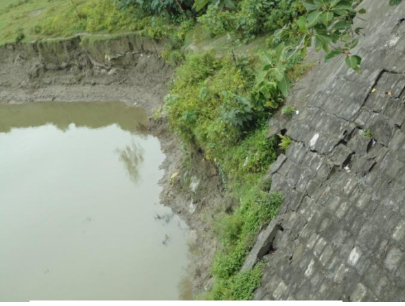
ক্ষতিগ্রস্থ প্রটেকশন ওয়ার্ক এর চিত্র
