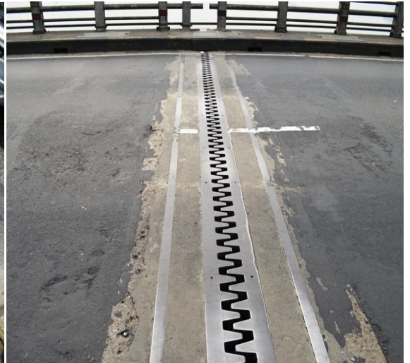
চিত্র ৬: পরিদর্শনের সময় সেতুর উপরস্থ Expansion Joint
