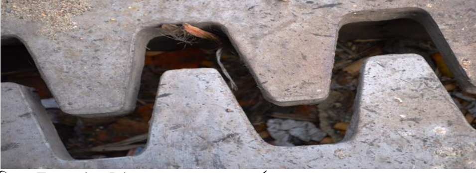
চিত্র ৭: Expansion Joint-সমূহের অভ্যন্তরে আবর্জনা
