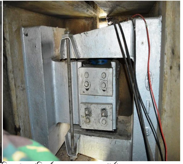
চিত্র ৪: পরিদর্শনের সময় বক্স-গার্ডারের অভ্যন্তরের Hinge এবং Expansion Joint-সমূহ
