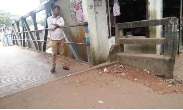
**চিত্র- ৬:** এ্যাপ্রোচ রোডের উইং ওয়াল এবং ব্রিজের রেলিং-এর সংযোগ স্থলের ভাংগা ফলস ওয়াল
