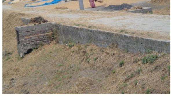
চিত্র - ৪: ক্ষতিগ্রস্ত সফট সোল্ডার এবং উন্মুক্ত গাইড ওয়াল সম্পন্ন রাস্তা
