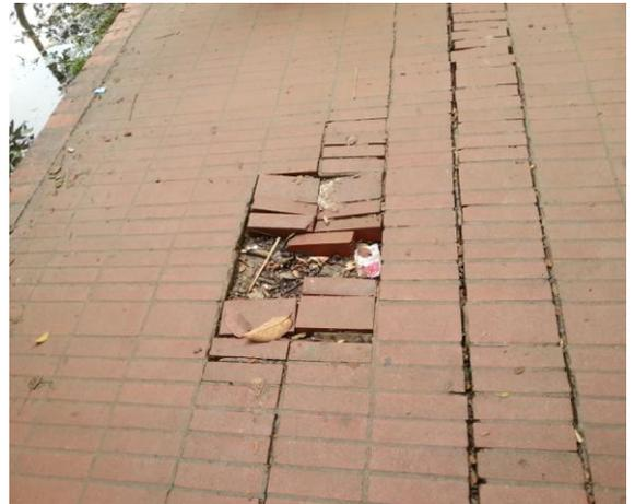
চিত্র- ১: পুরাতন ওয়াক ওয়ে এবং বর্ধিত ওয়াক ওয়ের মধ্যে সৃষ্ট ফাটল
