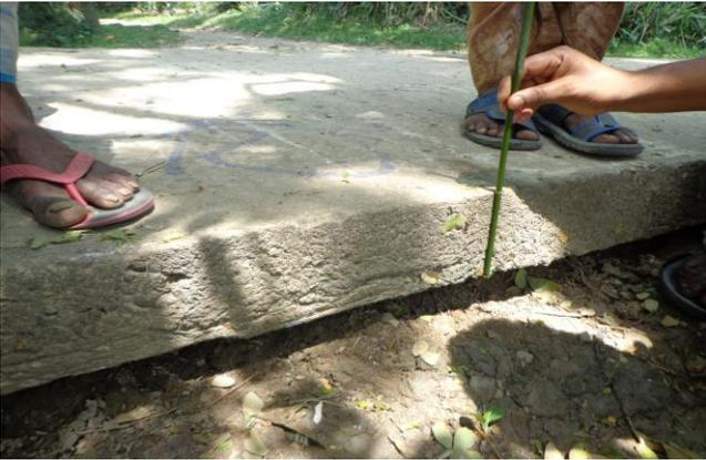
চিত্র - ৮: জয়কলস রাস্তার ক্ষতিগ্রস্ত সোল্ডার
