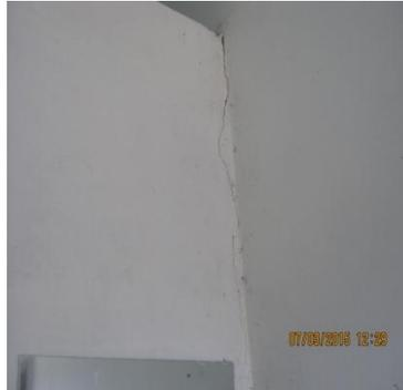
চিত্রঃ গবেষণাগারের টয়লেটের দেয়ালের ফাটল
