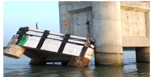
চিত্র-৬: দপদপিয়া সেতুর ক্ষতিগ্রস্ত গাইড ওয়াল
