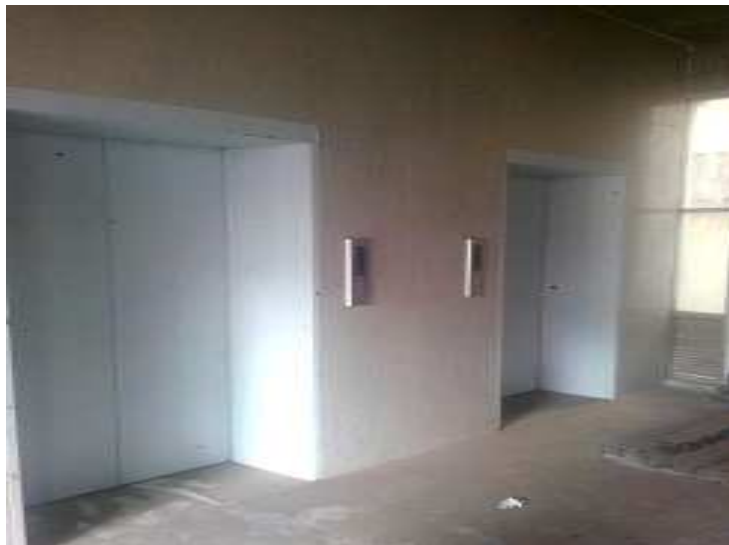
ভবনে স্থাপনকৃত ২টি লিফট কমিশনিং চলছে
