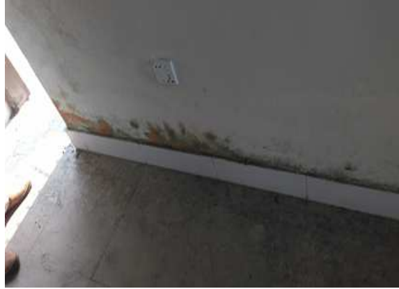
চিত্র-৯: হাসপাতালের ৫ম তলায় দক্ষিণ পাশের একটি ওয়ার্ডের দেয়াল ড্যাম্প হয়ে গেছে
