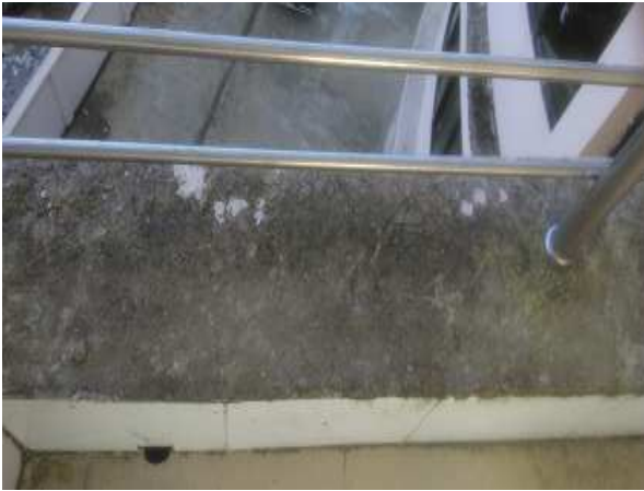
চিত্র-৯: ২য় তলায় বারান্দার পূর্ব প্রান্তে রেলিং-এর নীচে প্লাস্টারের রং উঠে গেছে
