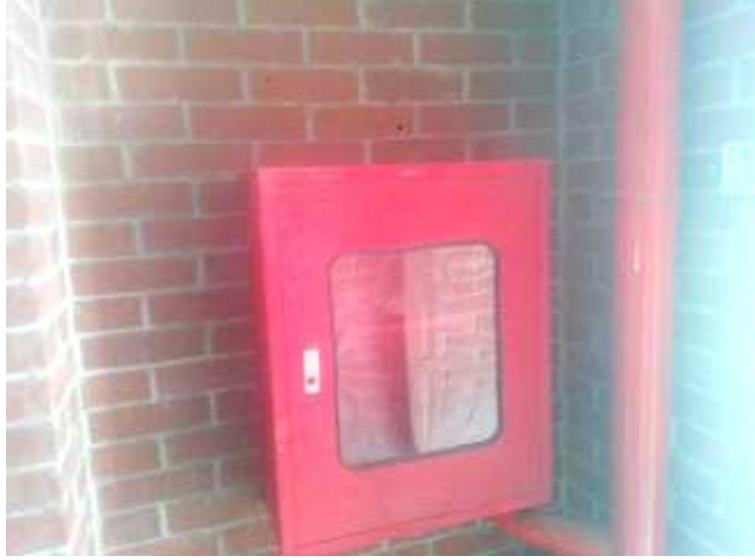
Fire Hydrant এবং Fire Extinguisher-এর ইকুইপমেন্ট স্থাপন বাকি রয়েছে
