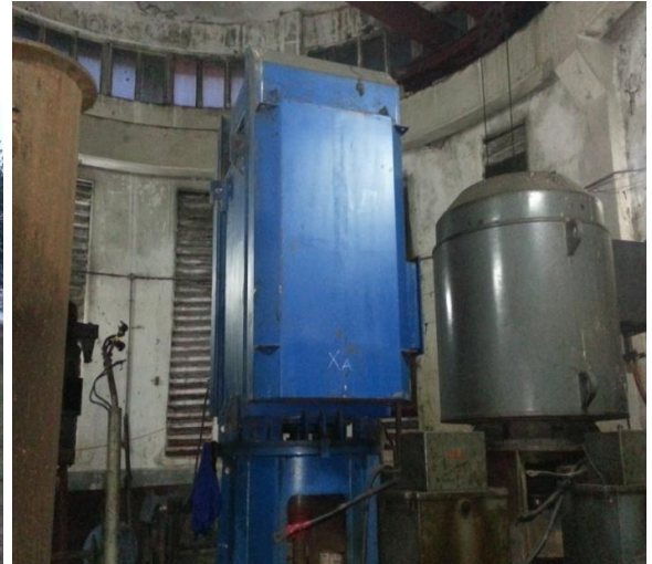
চিত্র-১১ : পানিউত্তোলনের জন্য মটরসহ ভার্টিকাল সেন্ট্রিফিউগাল পাম্প
