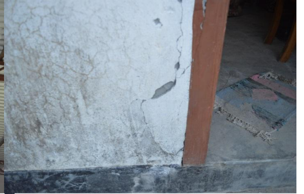
চিত্র-১০: বিক্রয় ও প্রদর্শনী কেন্দ্রের দরজার ক্ষতিগ্রস্ত চৌকাঠ
