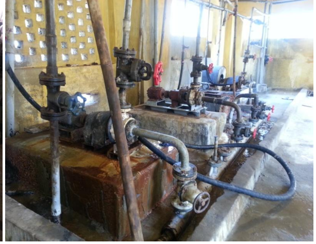
চিত্র-৫: হাইড্রলিক এসিড ট্রান্সপার পাম্প
