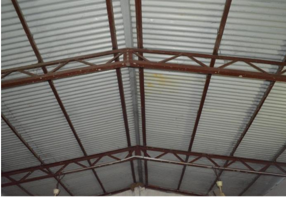
চিত্র-৯: বিক্রয় ও প্রদর্শনী কেন্দ্রের মরিচা পড়া লোহার সিলিং
