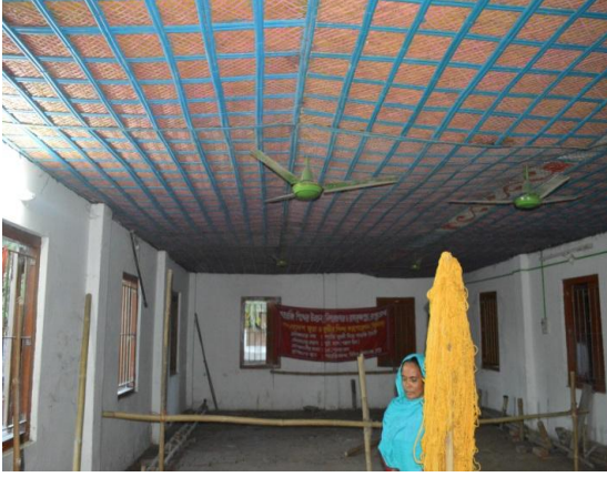
চিত্র-৩: বিদ্যমান ভবনের কক্ষে নির্মিত ফলস সিলিং
