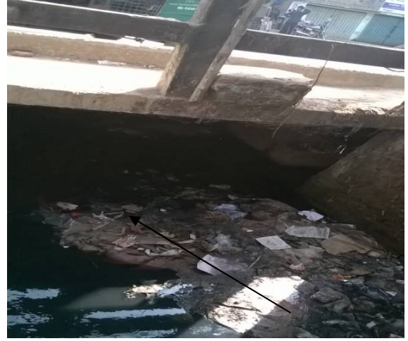
চিত্র (৬) : নির্মিত বক্স কালভার্টের নিচে জমা থাকা আবর্জনার স্তুপ।
