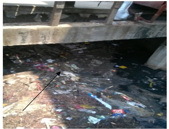
চিত্র (৪) : নির্মিত কালভার্টের নিচে জমা থাকা আবর্জনার স্থাপ।
