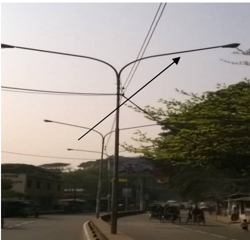
চিত্র (৯) : চট্টগ্রাম কলেজের সামনে নির্মিত রাস্তায় স্থাপিত সোডিয়াম লাইট।
