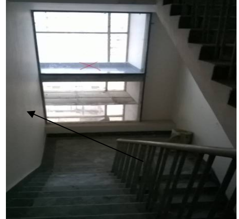
চিত্র (১২) : দ্রুত বর্হিগমন সিডিতে ফায়ার এ্যালার্ম বেল ও অগ্নি প্রতিরোধক দরজা স্থাপন করা হয়নি।
