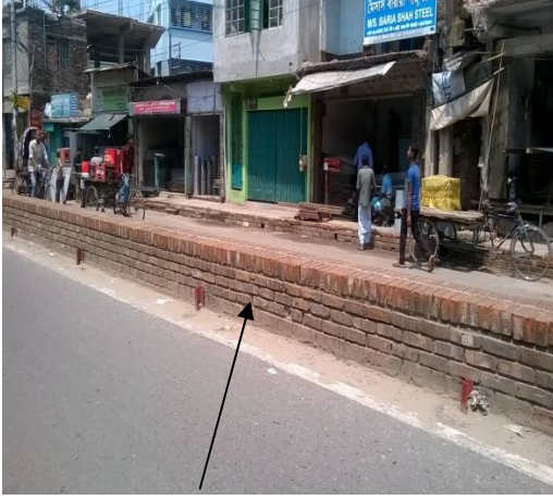
চিত্র (৯) : ইটের নির্মিত রোড ডিভাইডার।
