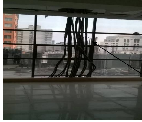
চিত্র (১৪) : ডার্ক বোর্ড বিহীন বুলন্ত তারের নমুনা।
