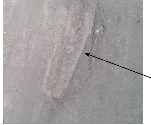
চিত্র ৮: রাস্তার মাঝে ক্রাকের চিত্র
