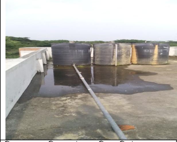
চিত্র (৯) : সরাসরি ছাদের উপর স্থাপিত পানির ট্যাংক।
