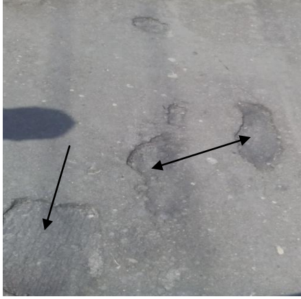
চিত্র ৭: রাস্তার মাঝে পটহোলের চিত্র
