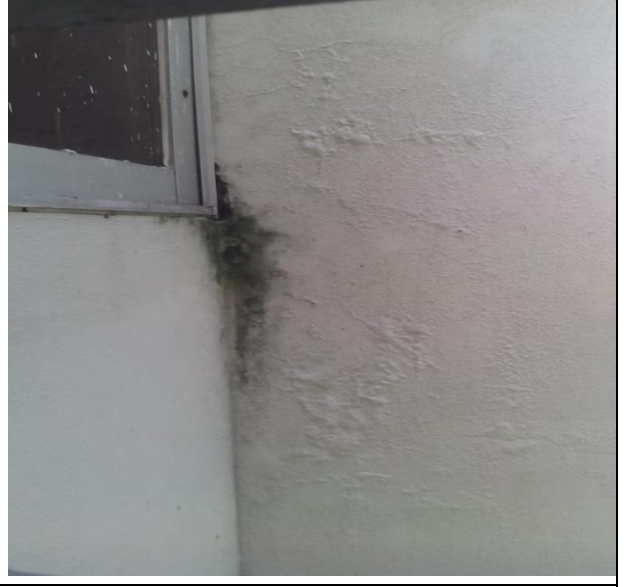
চিত্র (১৪) : ভবনের পিছন দিকে বাথরুম বরাবর ফাটলের নমুনা।
