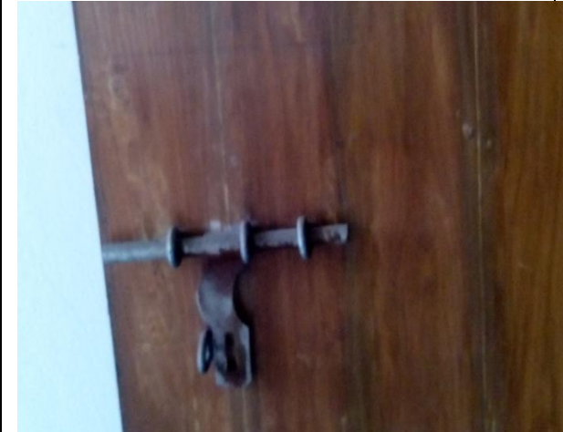
চিত্র (১১) : মরিচাপড়া হাতলের নমুনা।
