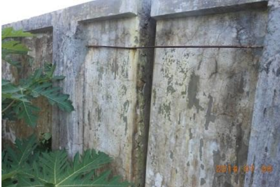
উপজেলা প্রাণিসম্পদ উন্নয়ন কেন্দ্র, সোনাইমুড়ি, নোয়াখালীর বাউন্ডারি ওয়াল হেলে গেছে এবং ভবনের এ্যাপ্রোচ বসে গিয়ে সৃষ্ট ফাটল
