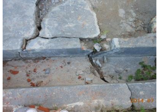
উপজেলা প্রাণিসম্পদ উন্নয়ন কেন্দ্র, সোনাইমুড়ি, নোয়াখালীর বাউন্ডারি ওয়াল হেলে গেছে এবং ভবনের এ্যাপ্রোচ বসে গিয়ে সৃষ্ট ফাটল
