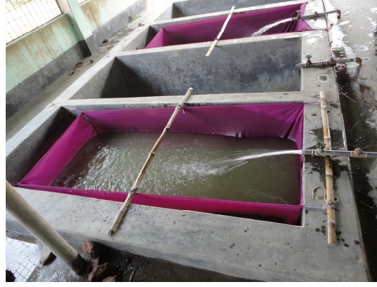
চিত্রঃ উল্লাপাড়া হ্যাচারিতে সিসটার্ন নির্মাণ
