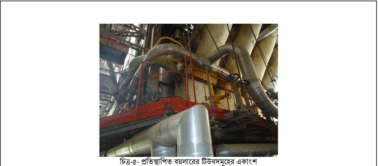
চিত্র-৫- প্রতিস্থাপিত বয়লারের টিউবসমূহের একাংশ
