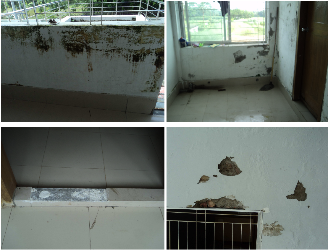
চিত্র: ৮ ভবনসমূহের দেয়ালের বিভিন্ন জায়গায় প্লাস্টার খসে পড়েছে এবং অফিস ভবনের বিভিন্ন জানালা সংলগ্ন দেয়ালের উপরের প্লাস্টার মারাত্মকভাবে ক্ষয় হওয়া অবস্থায় দেখা যায়। ডরমেটরীর দরজাগুলোতে লাগানো ডোরসিল এর টাইলস খসে পড়েছে।
