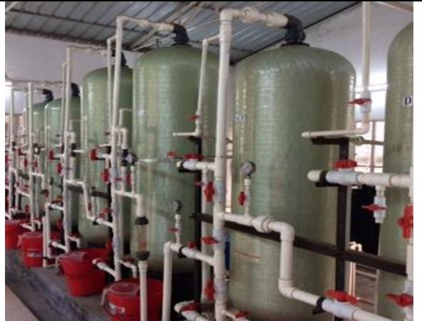
চিত্র-২: De-Ionized Water Plant (DIW)
