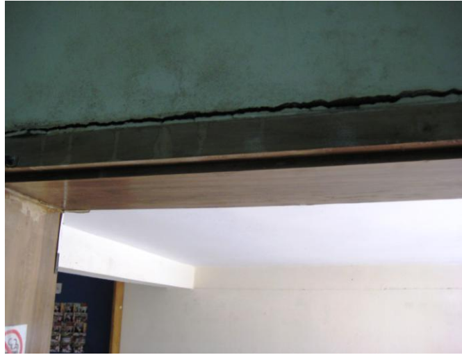
চিত্র ৪(খ): বর্তমান পাঠকক্ষের ভিতরের দেয়ালে ফাটল।
