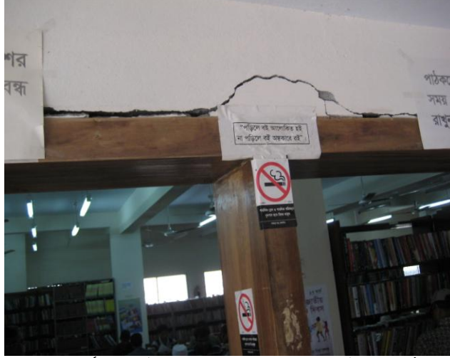
চিত্র ৪(ক)। বর্তমান পাঠকক্ষের প্রবেশমুখে দেয়ালের উভয়পার্শ্বের ফাটল।
