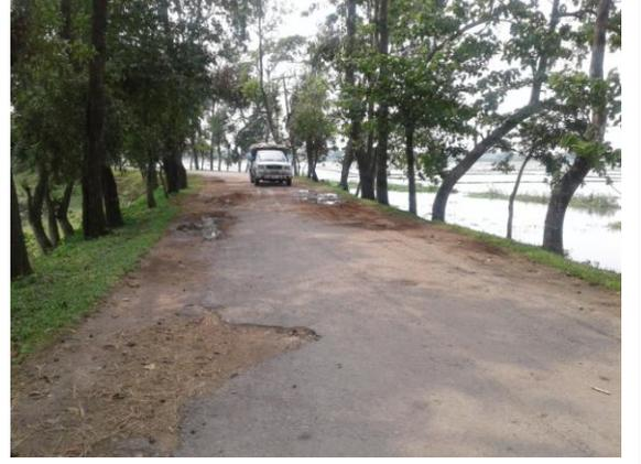
চিত্র-৪: পেভমেন্টে তৈরী হওয়া রেইনকাট ও পটহোলস
