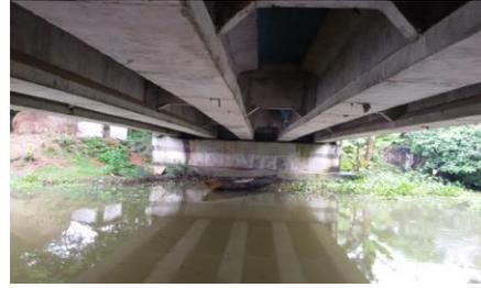
চিত্র-৭, ৮, ৯ ও ১০: কাঁঠালতলা সেতুর নিচে কালভার্টের ভাটিকেল ওয়াল, পল্লীমঙ্গল সেতুর উপর পানি ও নিচে ক্ষতিগ্রস্ত আরসিসি গার্ডার এবং আমড়াগাছিয়া সেতুর গার্ডার
