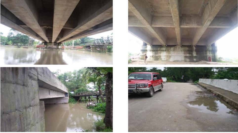
চিত্র-৭, ৮, ৯ ও ১০: পাগলার মোড় সেতুটির যথাক্রমে পিসি ও আরসিসি গার্ডার, বোর্ড অফিস সেতুর গার্ডার, আয়েশারহাট সেতুর উপর জমে থাকা পানি ও এপ্রোচের অতিরিক্ত ঢাল
