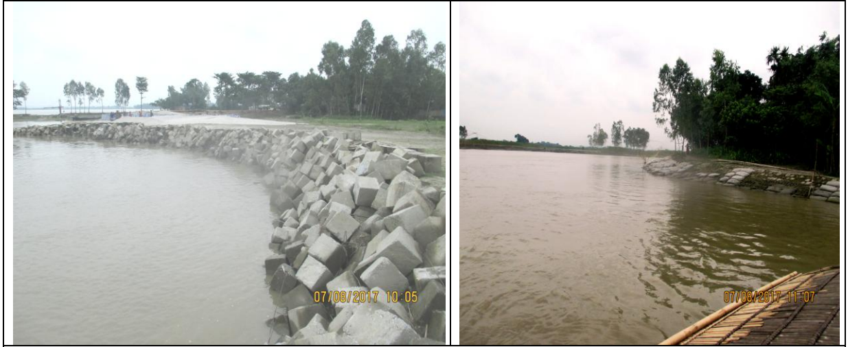
চিত্র-৭-৮: রৌমারী উপজেলার সাহেবের আলগা অংশে ক্ষতিগ্রস্ত প্রতিরক্ষা কাজ।
