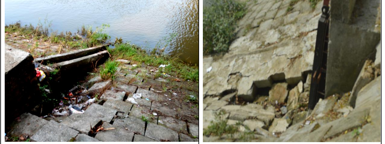
চিত্র-৫-৬: নওগাঁ শহর রক্ষা কাজের ব্লক ডেবে যাওয়ার খন্ড চিত্র।
