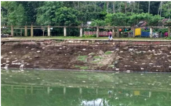
চিত্র-৩: ইনটেক চ্যানেলের ভেঙ্গে যাওয়া অংশ চিত্র-৪: ইনটেক চ্যানেলের স্লোপের ডেবে যাওয়া ব্লক
