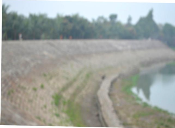
চিত্র-৩: বর্ণাই নদীর তীর প্রতিরক্ষা/সংরক্ষণ কাজ
