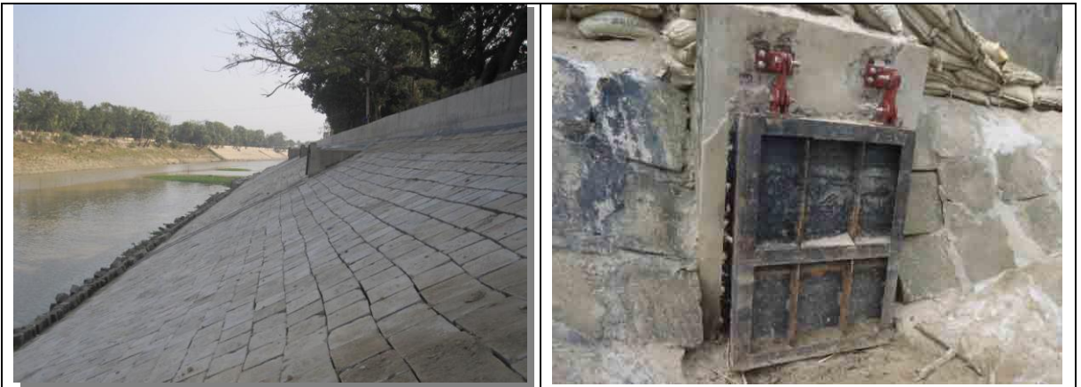
চিত্র-৭-৮: নওগাঁ শহর রক্ষা কাজে আউটলেটের খন্ড চিত্র।
