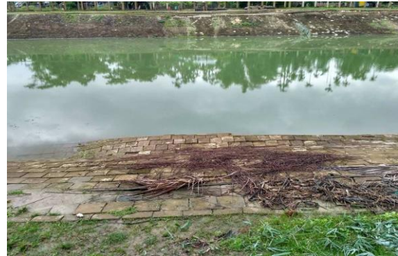
চিত্র-৩: ইনটেক চ্যানেলের ভেঙ্গে যাওয়া অংশ চিত্র-৪: ইনটেক চ্যানেলের স্লোপের ডেবে যাওয়া ব্লক
